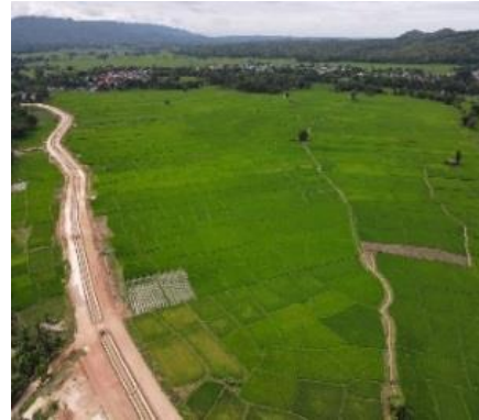
รูปที่ 1.5-2 ความก้าวหน้าระบบส่งน้ำพร้อมอาคารประกอบคลองส่งน้ำสายใหญ่ฝั้งซ้าย (LMC)
